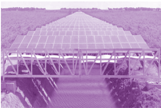
▲ 河川型太陽能光電系統
