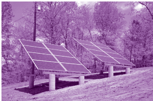
▲ 地面型太陽能光電系統
